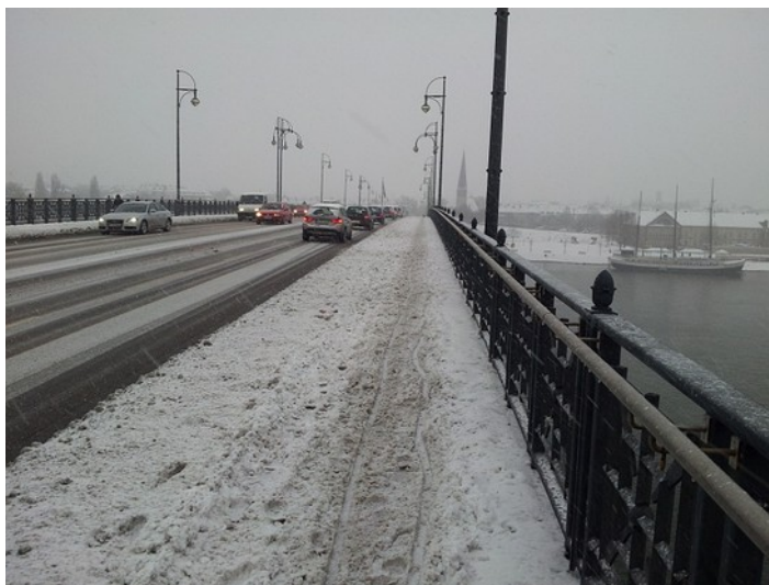
Winterspuren auf der rheinaufwärts gelegene Brückenseite (Foto: VCD Rheinhessen)
