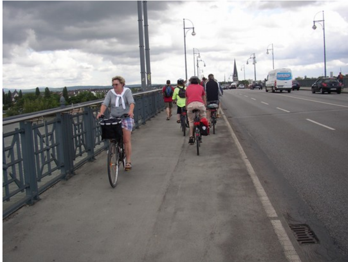
Fuß- und Radweg an der rheinabwärts gelegenen Brückenseite (Foto: VCD Rheinhessen)
