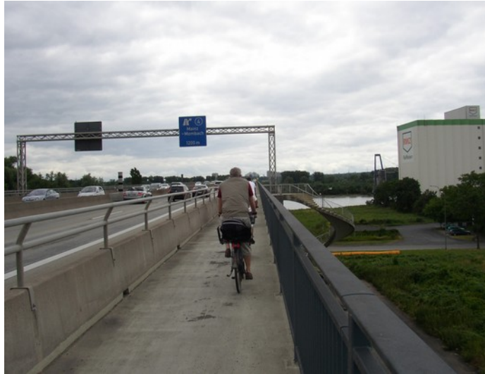
Auf der Schiersteiner Brücke (Foto: VCD Rheinhessen)
