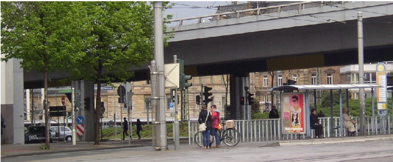
Blick zur Einmündung der Wallstraße (Foto: VCD Rheinhessen)
