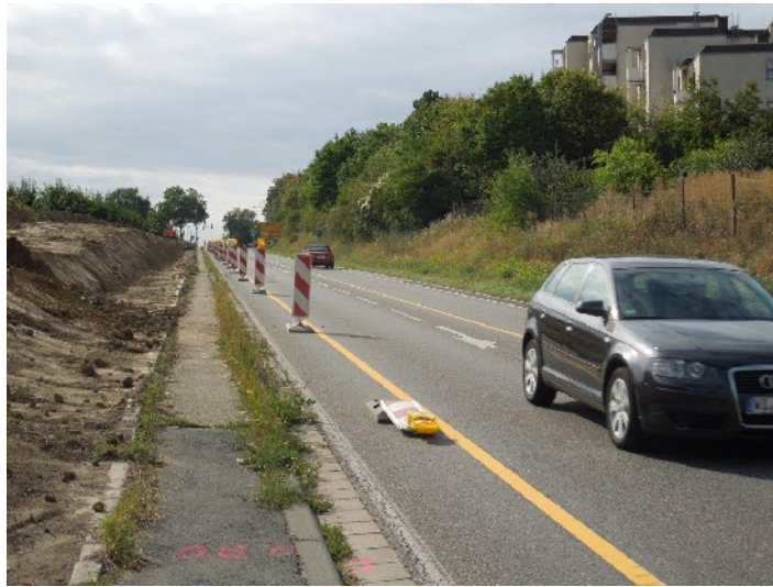
Blick auf die Baustelle (Foto: VCD Rheinhessen)
